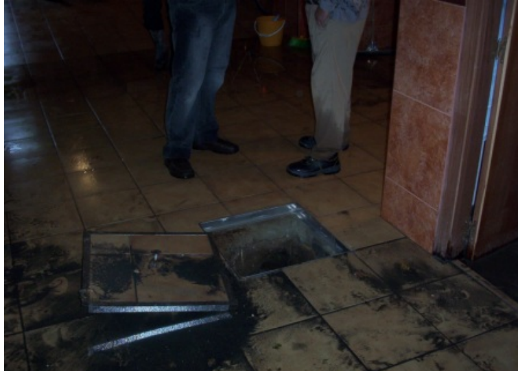
Estado del interior de una de las viviendas inundadas
