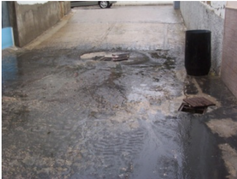
El lodo procedente del interior de las viviendas
