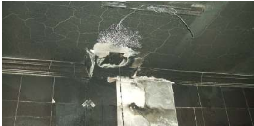
Posible origen del incendio, el extractor de la cocina
