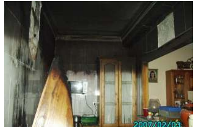
Estado en que quedó la cocina
